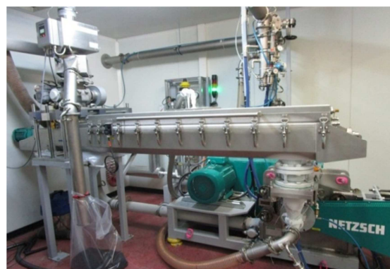
Figure 2 : Installation CONDUX 300 de Netzsch à SDTech
